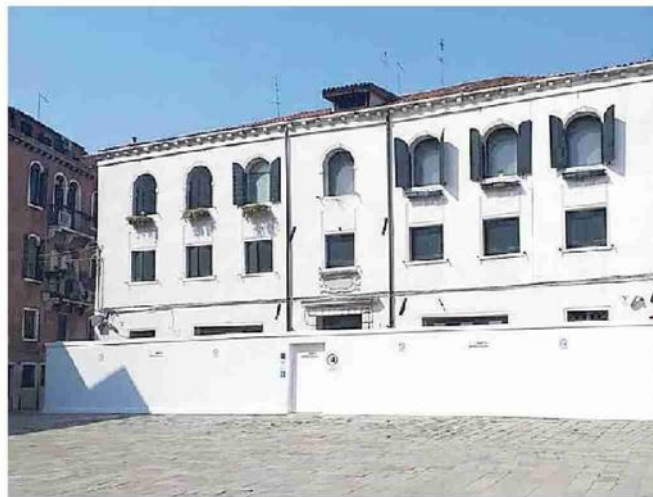
Partito il cantiere per realizzare il nuovo ristorante "la Vida"
