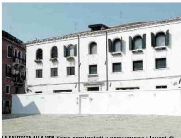
LA PALIZZATA ALLA VIDA Sono cominciati e proseguono i lavori di ristrutturazione della Vida, in campo San Giacomo, ma il Comitato dice no e chiede l'immediato stop
